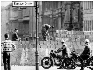
Bouw van de muur 1961
