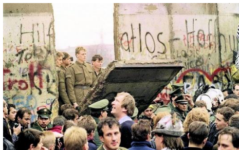
Sloop van de muur 1989
